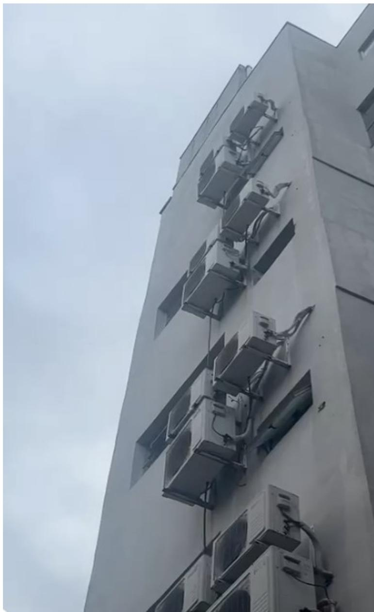
Figura 1: Condensadoras na parte externa do prédio
